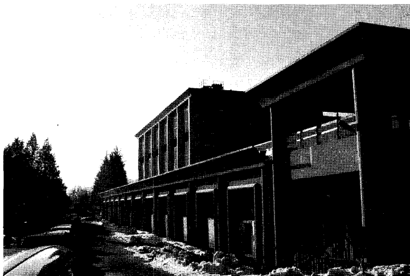
◀ 증축 중인 머시닝센터와 기술부 사무실
