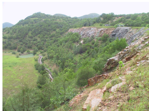
그림 9. Lamma 채석장 잔벽 식생복원 상황 근경(소단과 하단에 수로설치, 교목과 관목 식재).
