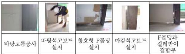
사진 1. 창호형 F몰딩 시공순서
