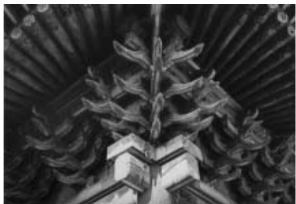
Fig. 6. 창경궁 명정전. 서까래와 부연은 아주 간결한 모로단청으로, 옛 단청의 장중한 모습을 비교적 잘 간직하고 있다. 국보 제226호.
