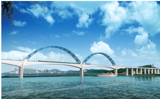
그림 1. Yichang-Wanzhou 철도 노선의 Yichang Changjiang River Bridge 조감도
