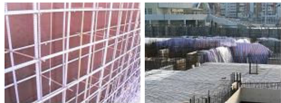
사진 3. 열선에 의한 벽 부재 보양 전경
