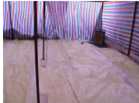
(d) 슬래브 양생 전경
