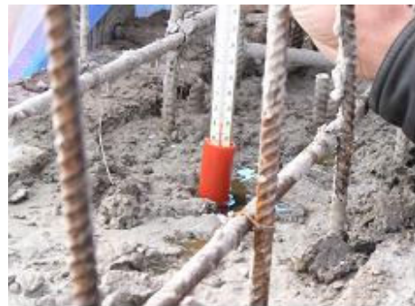
사진 6. 콘크리트 내부온도 측정 전경
