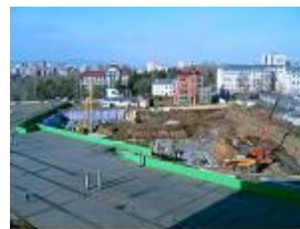
(a) 흙막이 및 터파기 공사
