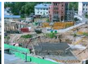
(b) 기초 콘크리트 타설
