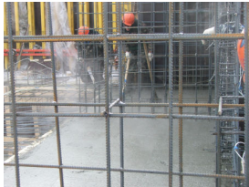
(e) -20℃에서의 콘크리트 타설 전경
