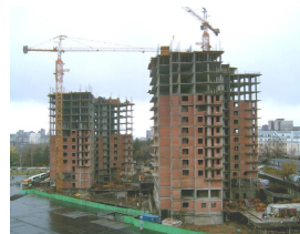
(e) 고층부 골조공사 및 벽체조적 공사
