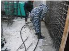
(c) 벽 부재 열선 매입 전경
