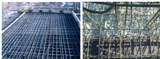
사진 2. 열선에 의한 슬래브 부재 보양 전경
