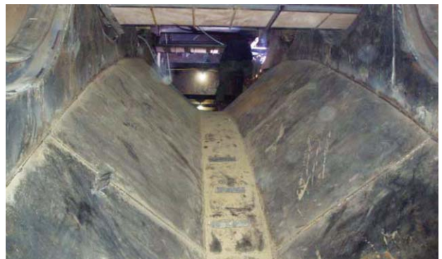
그림 6. C.A.M 철판 거푸집 설치
