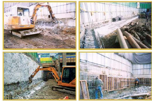
그림 6. 지하연속벽 시공 현장 사진
