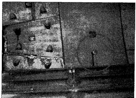
그림 5. 뒤채움 그라우팅 주입구에 지수제를 주입하는 방식
