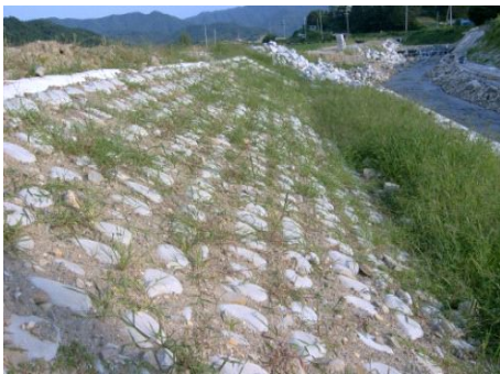
그림8 콘크리트 블록 호안공
