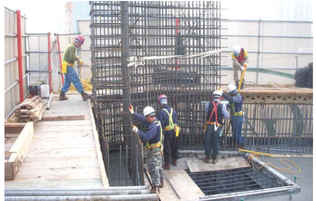
코어 벽체 철근 선조립 전경
