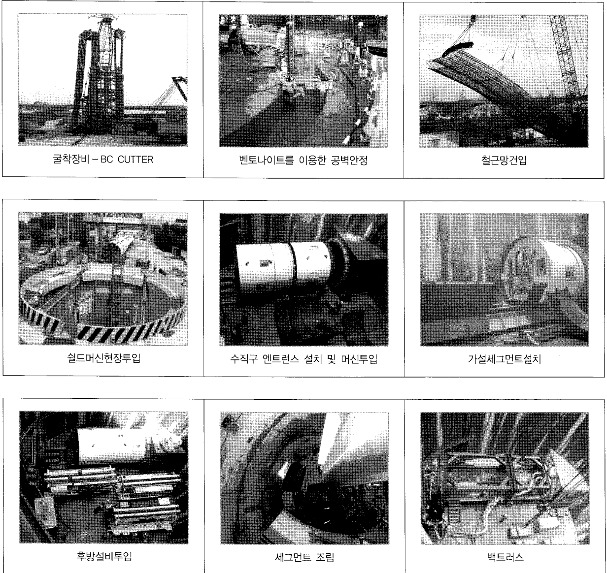
그림 3. 한강하저터널 쉴드TBM 작업구조성-초기굴진 공정현황도
