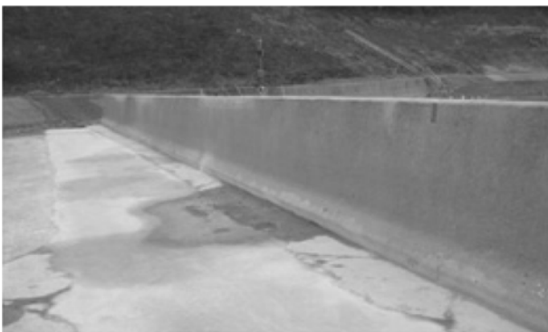
그림 7. New-F형 콘크리트 중분대용 방호울타리
