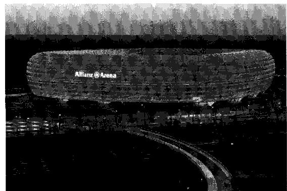
그림 4 알리안츠 아레나 시공 중 사진(상) 및 전경(하)
