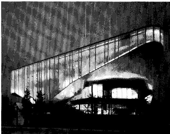
그림 12 부산 자이 주택문화관 전경(상) 및 야경(하)
