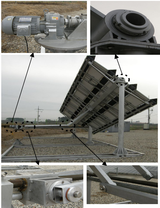
그림 6. 단축형 Tracking 시스템의 구동장치
