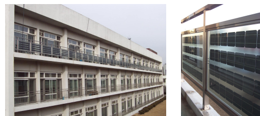
그림 2. 발코니 BIPV시스템이 설치된 건물 전경(좌), 발코니 BIPV모듈 상세(우)
