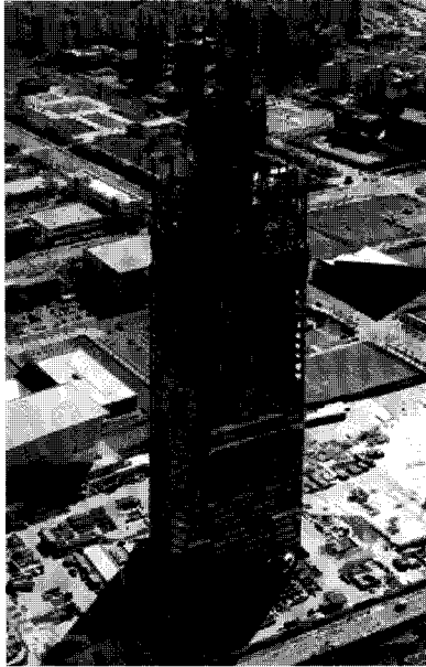
그림 1 송도ATT 현장의 시공 전경(2008년 11월)
