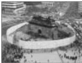
<그림 8> 화재 후 숭례문 남측 전경
