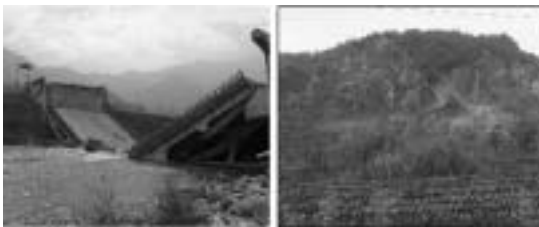
〈그림 16〉 교량 및 산사태 피해
