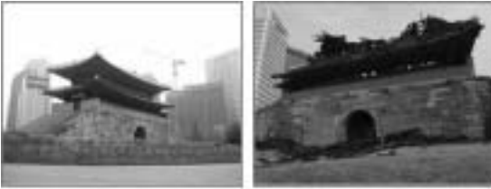
<그림 4> 숭례문 사고발생 전·후 전경
