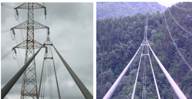
그림 5 복도체 스페이서 설치상태 Fig. 5 The twin spacers on 4 bundle lines
