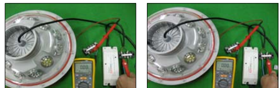
(f) 1차 단자(접지선)와 2차 단자(+극, -극)간의 절연 측정
