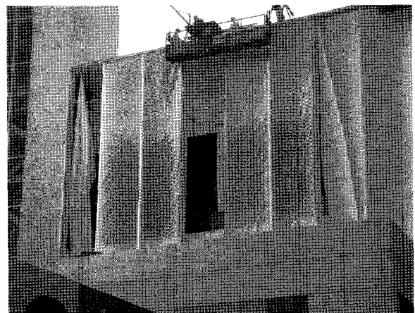
〈그림 17〉 벽부 시공 전경
