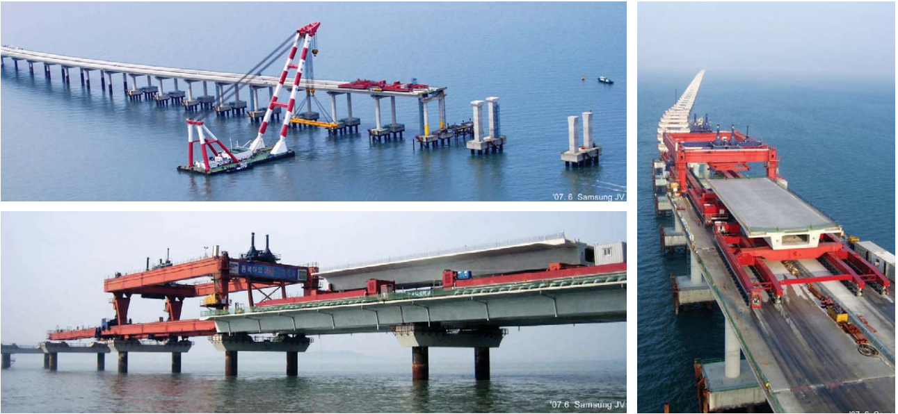
[그림 2] 고가교 가설전경 (Carrier, Launching Truss Girder, 2K Floating Crane)
