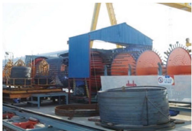
[그림 1] 철근망 제작 자동화 설비
