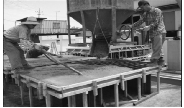
그림 11. 콘크리트 타설.
