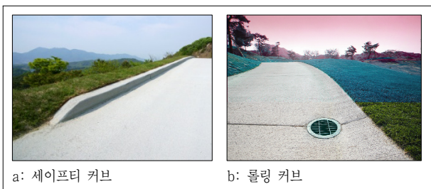
그림 10. 표면배수를 위한 카트도로 시공과 세이프티 커브와 롤링 커브 자료: 베어크리크 골프클럽, 2009. 필자 촬영
