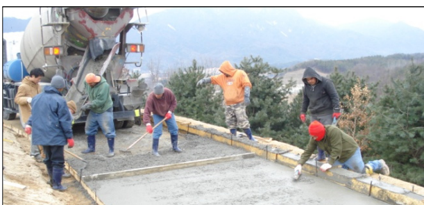
그림 6. 콘크리트 거푸집과 콘크리트 타설, 2009 자료: 베어크리크 골프클럽, 2009: 필자촬영
