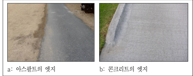
그림 8. 아스팔트와 콘크리트 엣지 관리비교 자료: 필자 촬영
