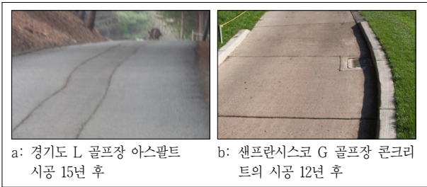
그림 7. 아스팔트와 콘크리트 카트도로 수명 비교 자료: 필자 촬영
