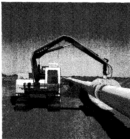
그림 8. 이동형 레이저 파이프 용접장치
