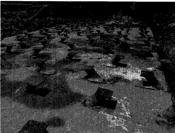
그림 1. 기초시스템 형태의 경사진 마이크로파일 시공(예)
