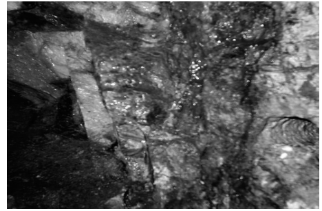
그림 9. 육안관찰에 의한 주입재 침투성확인(경부고속철도 00-0공구)
