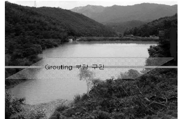
그림 5. 단층대 저토피터널 상부 저수지 담수 상태
