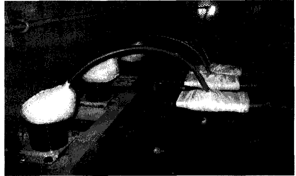
그림 3 고정자 권선 출력단 Capacitive Coupler 설치 Fig. 3 Capacitive Coupler installation at the stator winding output
