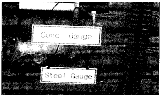
그림 4. 하중전이 게이지 설치
