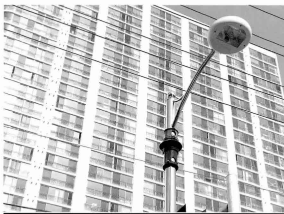
▶ 아파트에 설치된 테크윈 보안등
