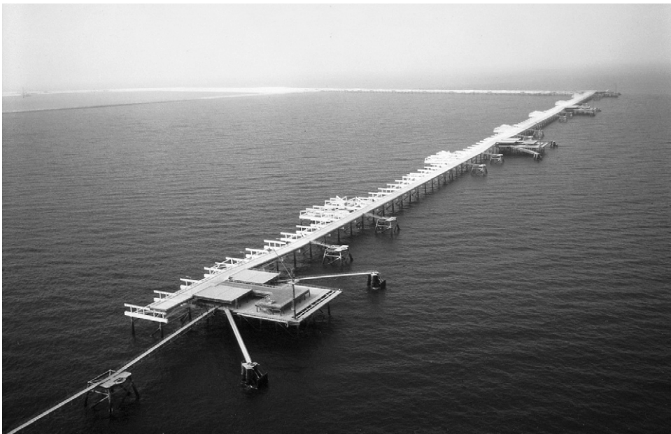
주베일 산업항 공사
