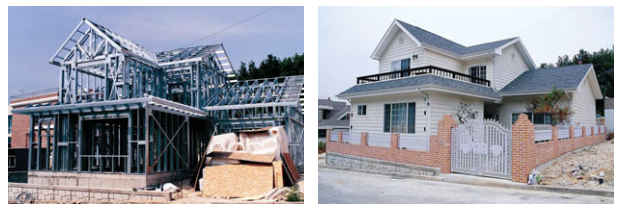
- PRY 트러스로 시공한 스틸하우스 -
