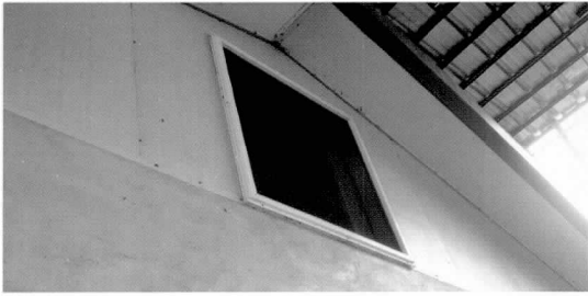
(위) 착유실 내 천정에 설치된 환풍흡입구, (아래) 착유실 밖 환풍배기구
