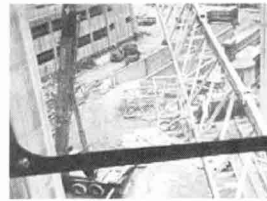
[1-7] 메인 지브 설치
