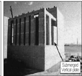
해수교환시설 시공 전경
