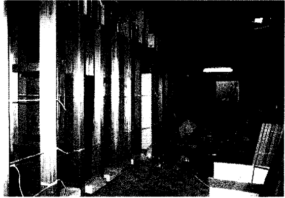
미술관 수장고의 내부, 습기를 제거하여 줌으로 미술품에 곰팡이의 발생을 막을 수 있기 때문에 내장을 목재로 함
