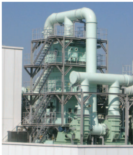
그림 6. 200,000CMH 배기가스 유해백연 제거 실증 시스템 사진
