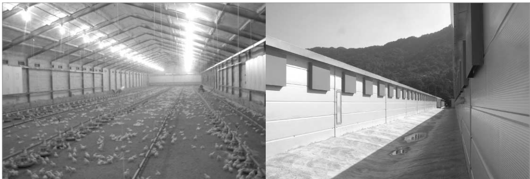
〈사진 1〉 무창계사 전환 농가의 내·외부 전경
