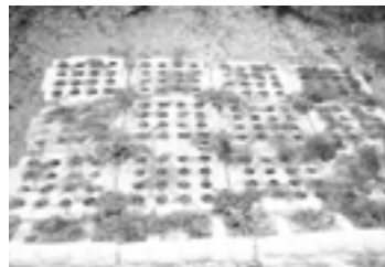
제작된 식생블럭 시제품을 이용한 시험 시공
