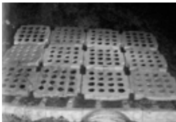
제작된 식생블럭 시제품을 이용한 시험 시공
