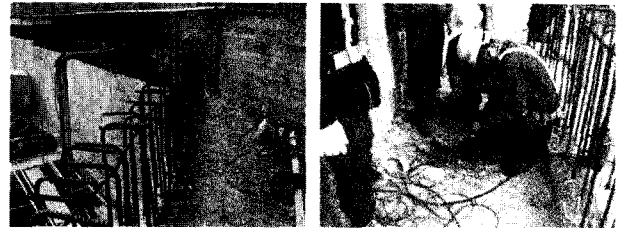
그림 13. 지하외벽 앵커 설치 및 테스트
