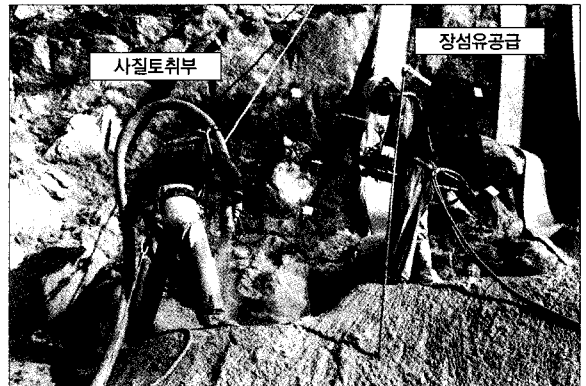
그림 8. 연속장섬유 보강토공의 축조 시공
