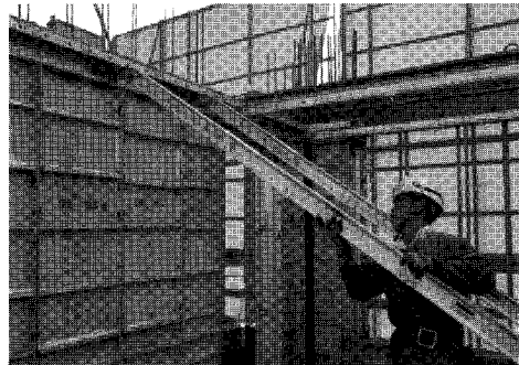
〈그림 3〉 서포트빔의 설치
