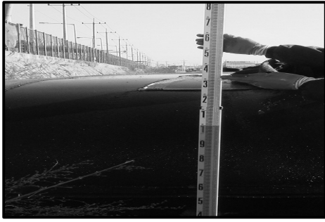
그림 4. 지오텍스타일 튜브 채움 후 높이 측정
