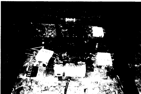
그림 10. 지하철 임피던스본드에 누설전류 저장장치가 설치되어 있는 전경
