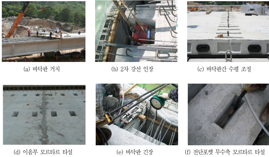
그림 5. 프리캐스트 바닥판을 이용한 PSC 거더교의 주요 공정
