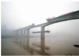
그림 2. Shibano Bridge(main span 330 m)
