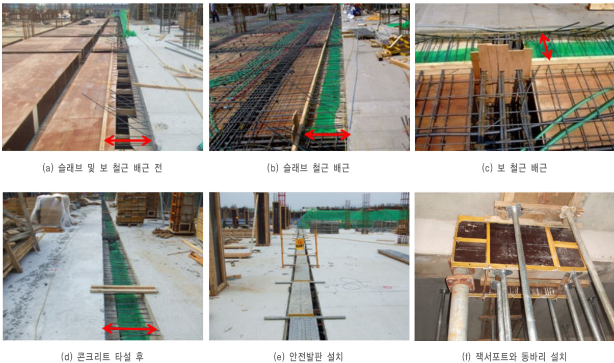
그림 5. Delay joint 시공 과정
