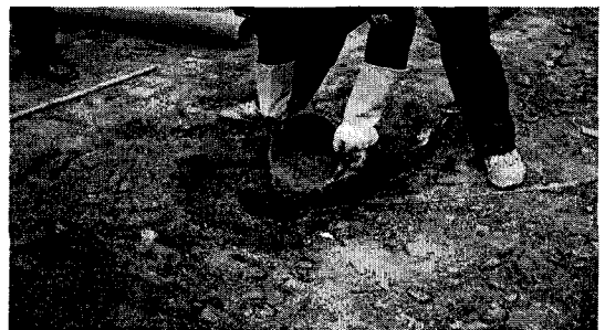
그림 10. 저감재 시공 Fig. 10. Filling the holes with the reducing materials
