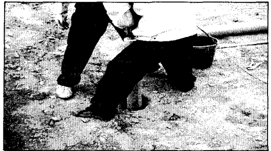
그림 9. 접지봉 투입 Fig. 9. Putting a ground rod
