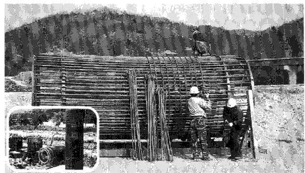
그림 1 JIG를 이용한 철근 케이지 선조립
