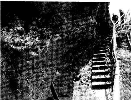
그림 4. 불완전한 공사로 인해 낙석 위험이 초래된 사면.
